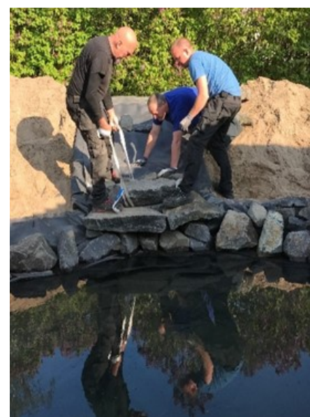
Bjarne, Stig og Torben bygger vandfald.
